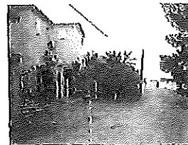
PHOTO ETAT DES LIEUX Grillage hauteur 1m50 sur muret hauteur 30cm (hauteur de clôture 1m80)
