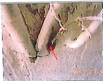
Photo n° PhGaz001
