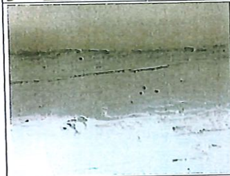
Photo n° PhTer003 Localisation : Appart 3 Rez de chaussée - Cuisine Ouvrage : Plafond - Charpente bois et peinture Parasite : Présence d'indices d'infestation ancienne d'autres agents de dégradation biologique du bois Indices : présence de trous de sortie, présence de vermoulure (dégradation(s) faible(s))
